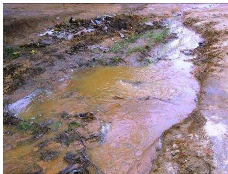
Vue d'un ruissellement d'eau causé par des fuites de la tuyauterie de la SNDE dans une rue du quartier Ohade à Makoua.
