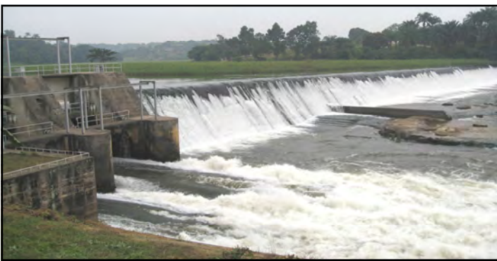
Barrage hydroélectrique du Djoué
