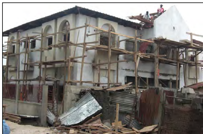
Siège des Affaires sociales de Makélékélé, en construction
