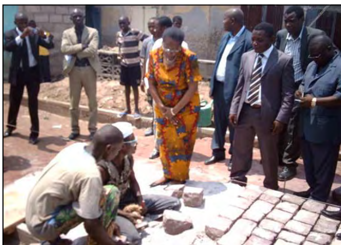
Le pavage de la rue des Boko (Moungali)
